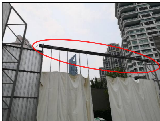
รูปที่ 2-20 เครื่องฉีดน้ำ (Sprinkler)
