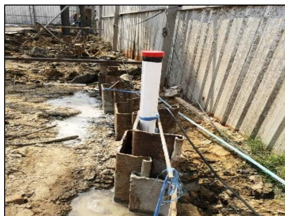
รูปที่ 2-11 อุปกรณ์ตรวจวัดการเคลื่อนตัวของดิน (Inclinometer)
