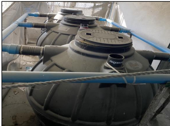
รูปที่ 2-44 ถังบำบัดน้ำเสียสำเร็จรูป
