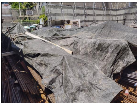
รูปที่ 2-21 ผ้าใบปิดคลุมกองวัสดุ/อุปกรณ์ก่อสร้าง
