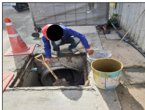
รูปที่ 2-43 กิจกรรมขุดลอกตะกอนที่สะสมในบ่อดักตะกอน
